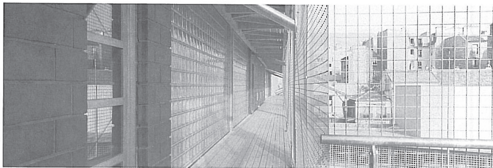
Vue de la façade sur cour : pavés de verre et coursives grillagées.
