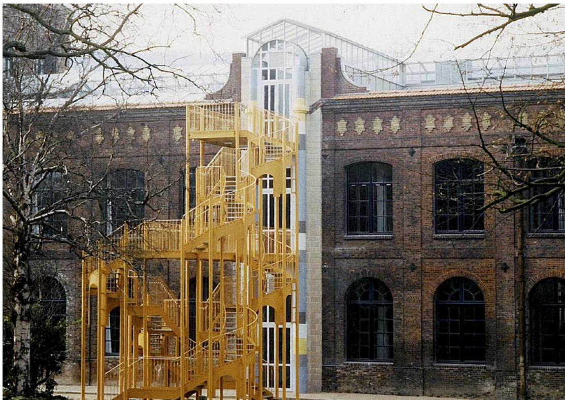
La façade après la réhabilitation
