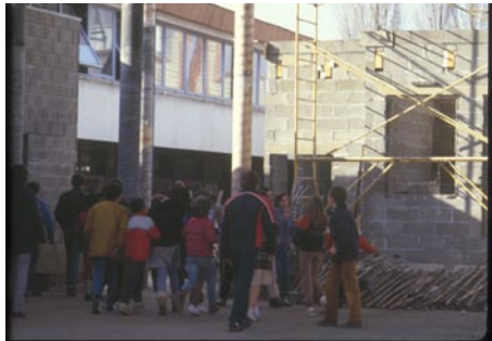
Les collégiens regardent le chantier
