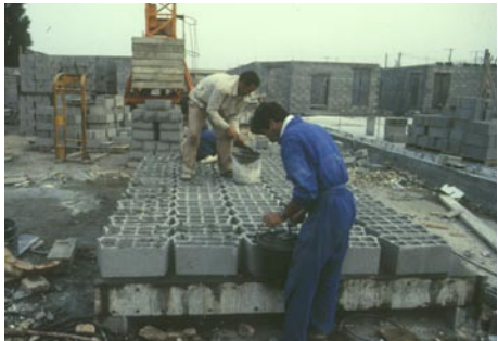
Mise au point de parpaings phoniques sur le chantier
