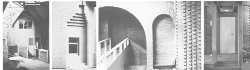
Parpaings et lamellé collé pour les Retentis, Cergy. // Breezeblocks and glued laminate for washrooms. Traitement d'angle en parpaings. Ces de Brionne, Beaulieu, dans l'Eure. // Angle in ordinary breezeblocks for Brionne school, Beaulieu. La brique comme support et motif décoratif dans la Maison des Prés à Beaulieu, dans l'Eure. // Brick plays structural and decorative role in Maison des Prés at Beaulieu. Rez-de-chaussée de la Maison des Prés. // Groundfloor of Maison des Prés.
